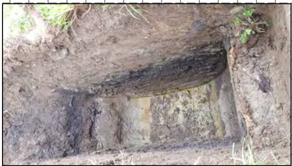
Test pit met target depth at 2 m. Scala Penetrometer met target depth at 2 m.
